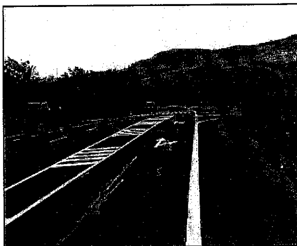
Obr. 56 Podkriváň - súčasná cesta I/50 v mieste odbočenia na Starú Hutu, trasa navrhovanej cesty R2 vedie na svahoch na ľavej strane cesty
