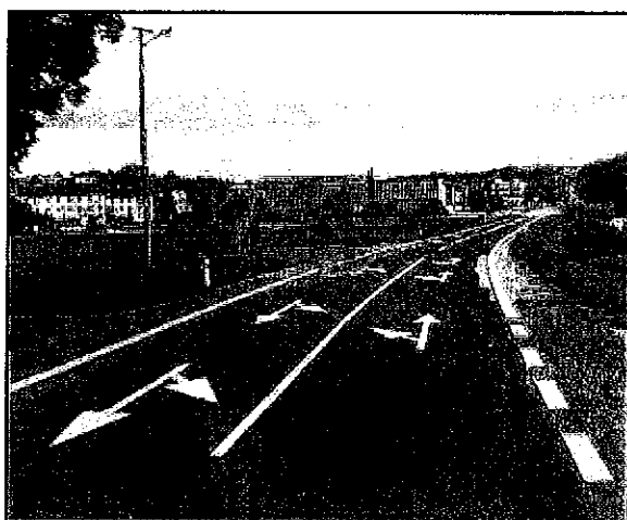
Obr. 41 Detva - miesto napojenia privádzačov cesty R2 na cestu I/50 a mesto Detva
