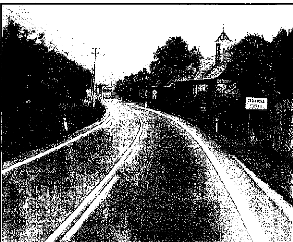
Obr. 18 Zvolenská Slatina - vedenie súčasnej cesty I/50 obcou, vybudovaním cesty R2 bude doprava z obce odklonená
